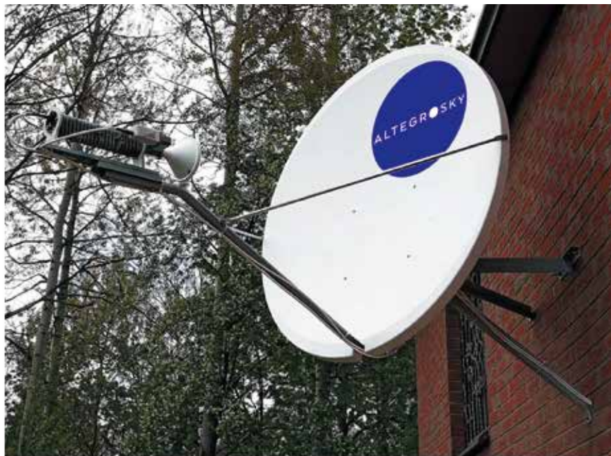
Рис. 12. Комплект внешнего радиочастотного оборудования с антенной 1,2 м
